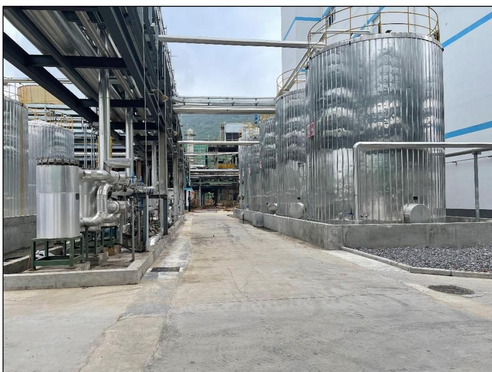
图 4.2-1 PVB 分厂物料罐区（硬化地面及围堰）
